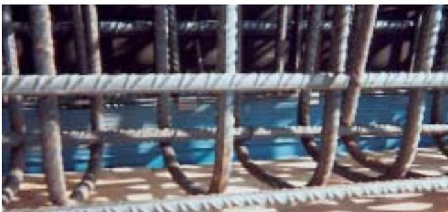
MASTERFLEX 2000 PVC azules, tiene insertados en su propia estructura una serie de remaches metálicos al tresbolillo (3 cada metro lineal) con el fin de fijar la cinta a la armadura mediante un alambre.
