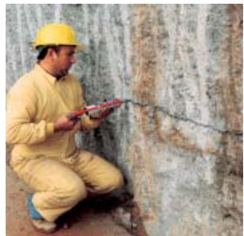
Los perfiles preformados ADEKA, gracias a su elevada capacidad de expansión, pueden ser utilizados en construcciones en contacto continuo con agua, con presiones de hasta 8 bar sin que se produzcan fugas; incluso en zonas donde se sucedan ciclos de variación de niveles freáticos (periodos húmedos/secos).
