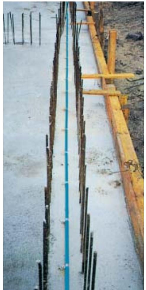
A ambos lados de la pieza de dilatación le siguen las secciones selladoras, las cuales no se deforman por los movimientos de las juntas. En los perfiles así como a lo largo de la cinta se encuentran los nervios y refuerzos.
