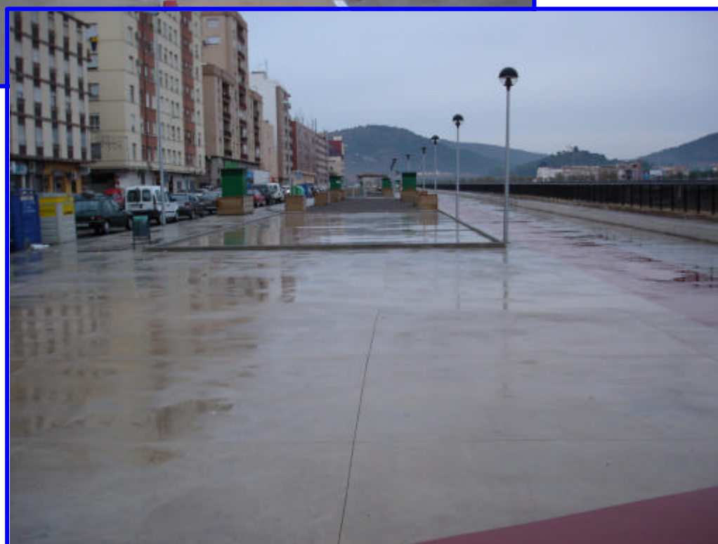
Vista General del aparcamiento subterráneo Sants de la Pedra, acabado.
