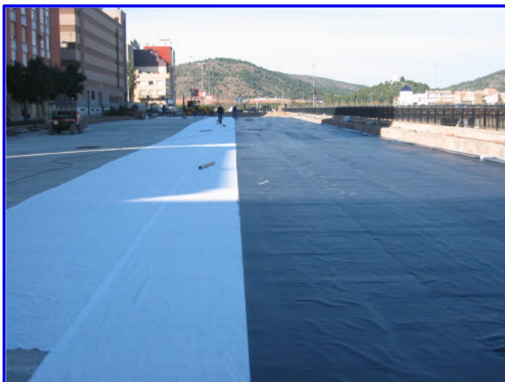
Vista General de la cubierta en fase de impermeabilización.
