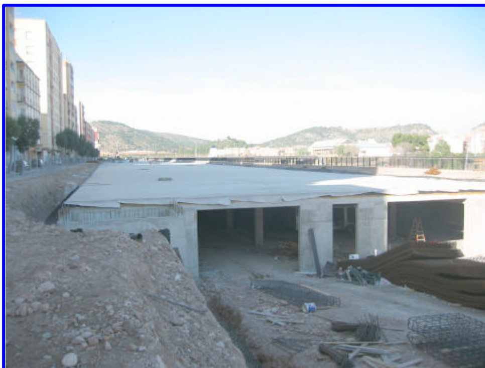
Vista General del aparcamiento subterráneo en fase de construcción.
