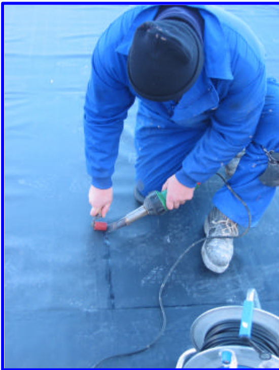
Solapes transversales
