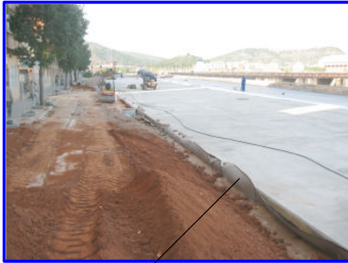
DELTA NP DRAIN en muro perimetral cubierto con tierras compactadas.
