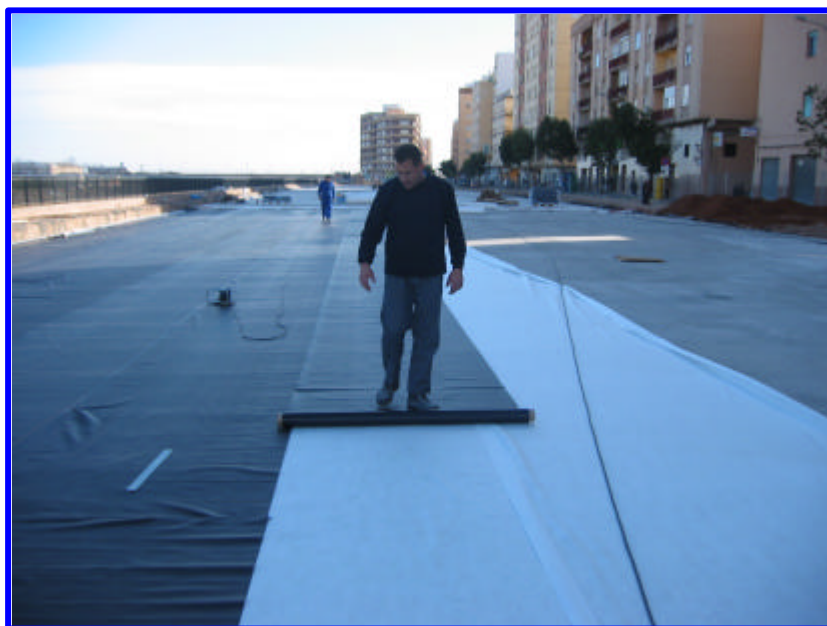
Extensión del NOVANOL FV NI
